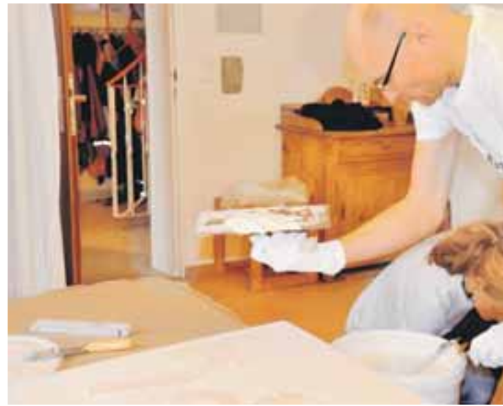
ZVEI-Helfer Thorsten Meier schmiert Kleber auf die Lärmdämmplatte. MALTESER (3)
